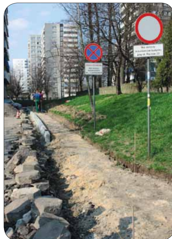
Remontowany podjazd przy ul. Piastów 22.
