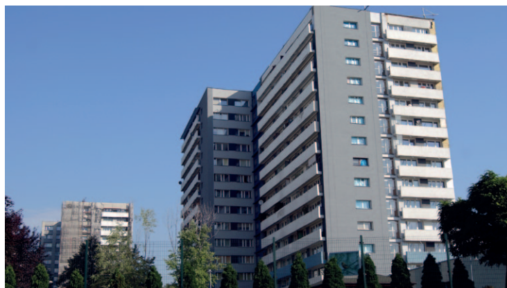
Termomodernizacja budynku Piastów 18, w tle termomodernizacja budynku Piastów 10
