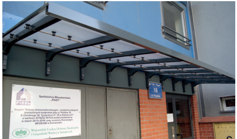
Zadaszenie wejść głównych do budynku przy ulicy Piastów 16
