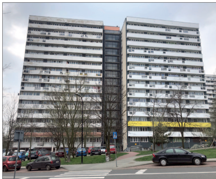
Ul. Chrobrego 43 – remont elewacji
