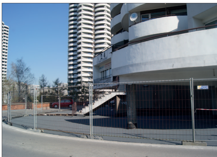
Ul. Zawiszy Czarnego 4 – budowa miejsc parkingowych ➔
