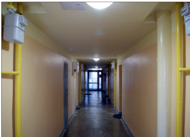
Ul. Ułańska 7—remont korytarzy lokatorskich
