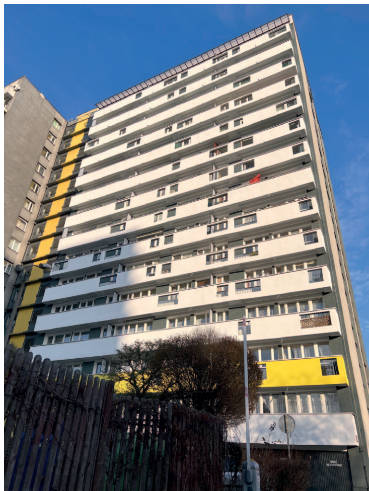
Chrobrego 31 - remont elewacji segment garażowy strona zachodnia
