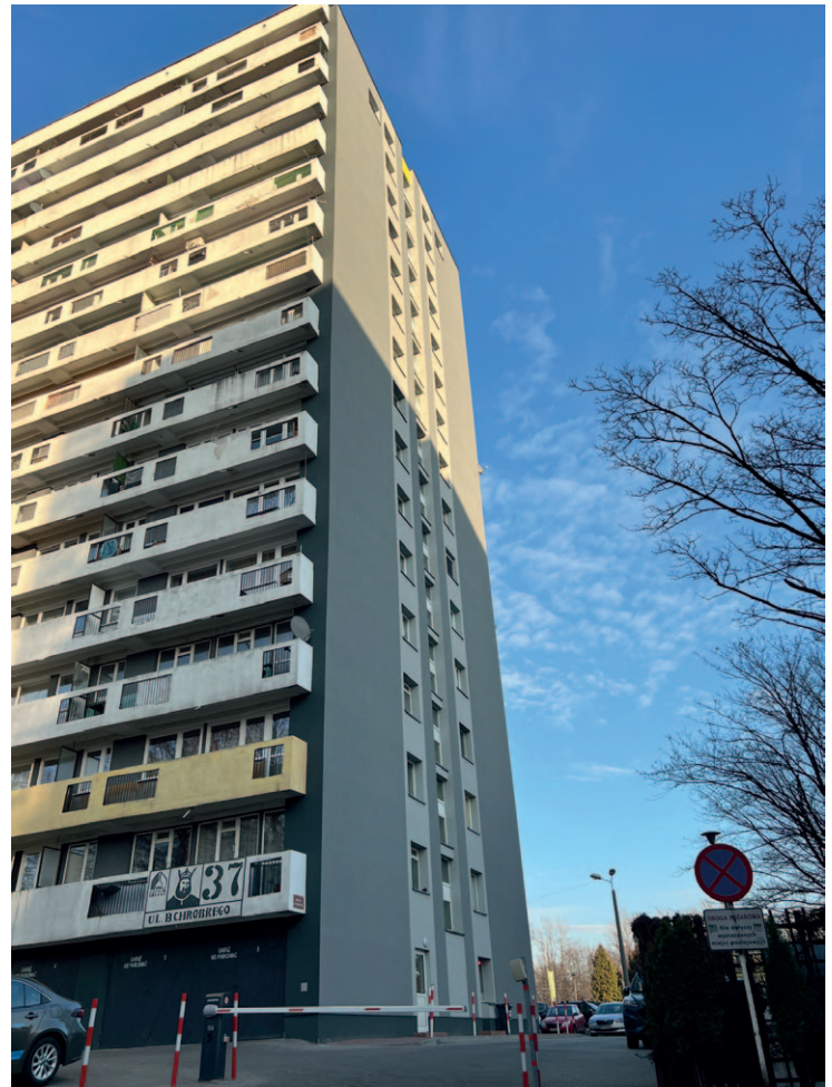
Chrobrego 37 - termomodernizacja ścian szczytowych segment garażowy
