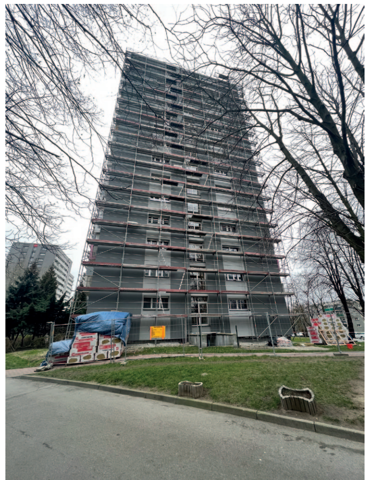
Tysiąclecia 47 - termomodernizacja ścian szczytowych
