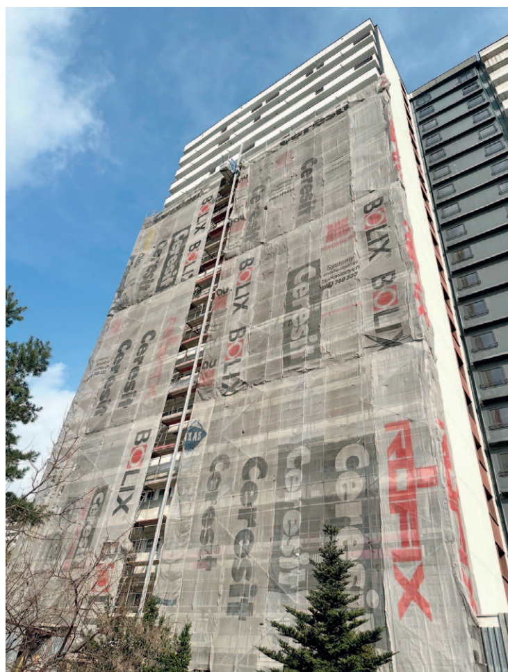
ul. Tysiąclecia 92 - remont elewacji
