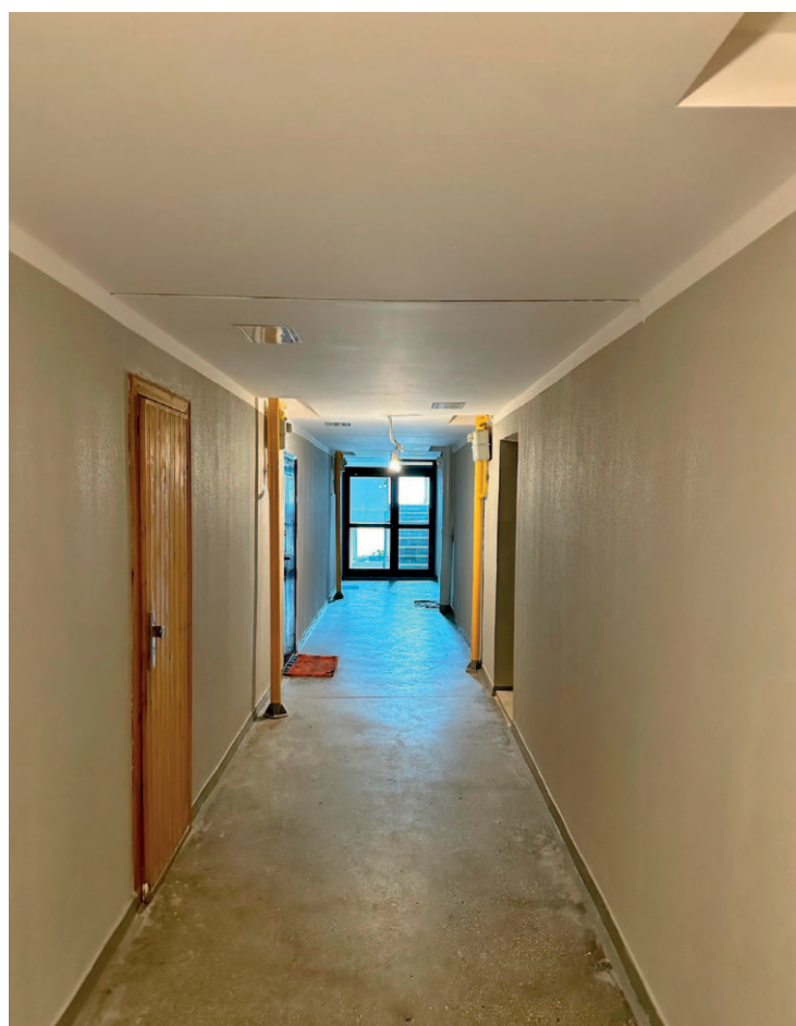
ul. Tysiąclecia 78 - korytarz lokatorski w trakcie remontu
